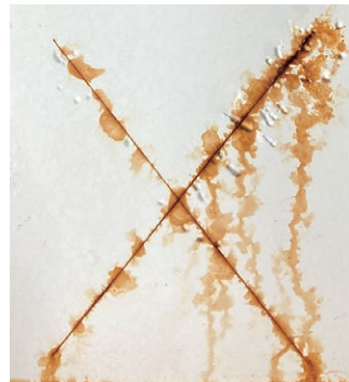
一般塩害対策高遮断下塗り (120μm)
