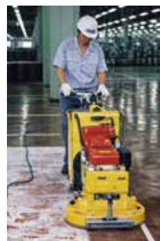
研削機による 既存塗膜の撤去
