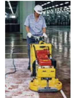
研削機による 既存塗膜の撤去
