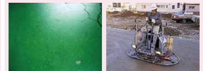
(例3)強化コンクリート・カラーコンクリートや機械押えによる緻密なコンクリート
